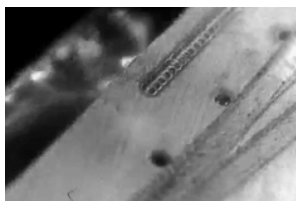
平板焊接监控
